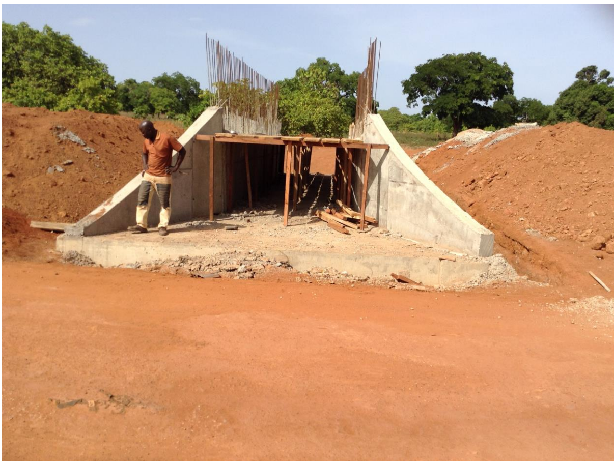
OHN°3 dalot (1x2.5x1.5) implanté au pk4+215 BP ,radier piédroits exécuté à 100% coffrage tablier en cours
