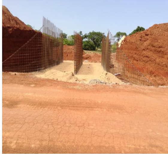
OH N°6 dalot (2x3x3) implanté au pk8+384.92 radier coulé à 100%
