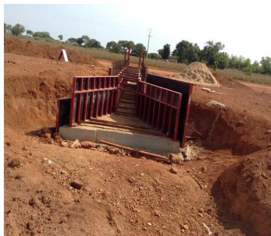
OH N°5 dalot (1x1x1) implanté au pk7+03 radier exécuté à 100% coffrage piédroits en cours.
