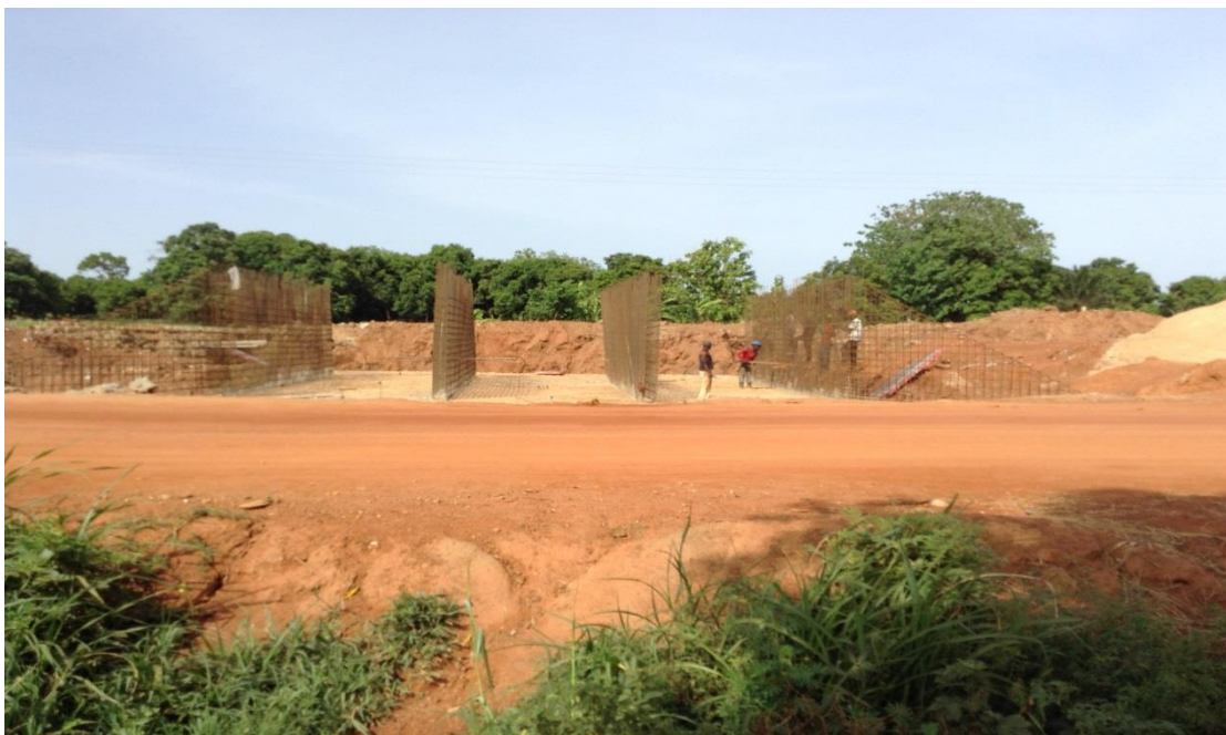
OHN°1 dalot (3x4x3) implanté au pk2+100, fouille, béton de propreté, béton de radier exécutés à 100% ferrailage radier en cours
