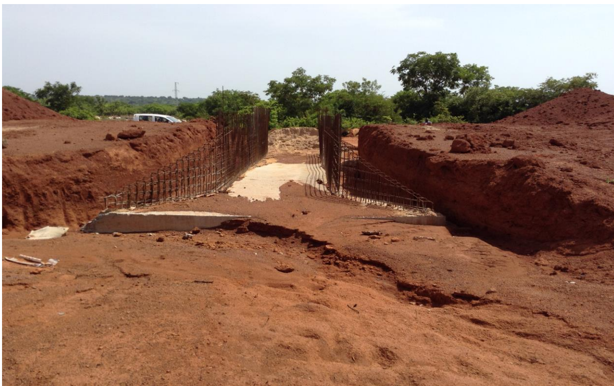
OH N°9 dalot (1x2x1) implanté au pk11+182 béton radier coulé à 100%
