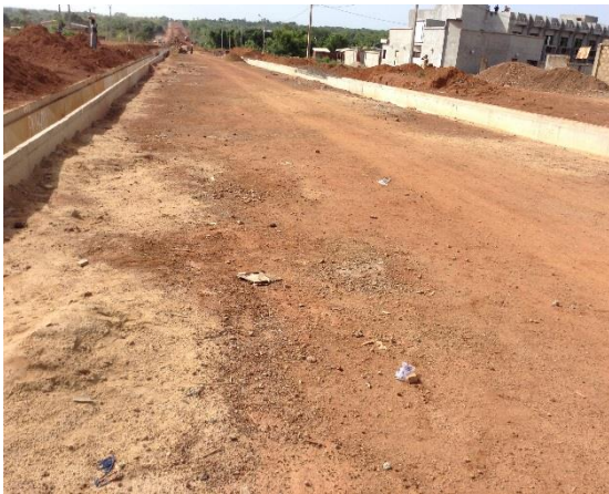
PK1+165 caniveaux côté droite (80x80) et côté gauche(80x80) achevés
