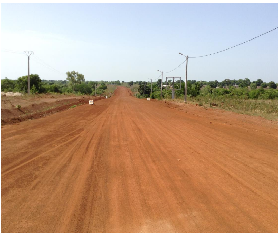
Bretelle de l'aéroport couche de fondation exécutée du pk0+100 au pk1+750.
