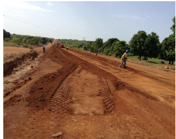
Mise en œuvre de la couche de fondation entre le pk1+850 et le pk2+050
