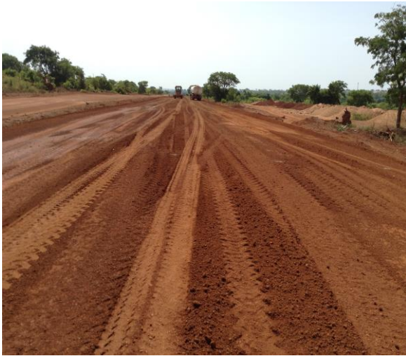
Réglage couche de fondation entre le pk7+150 et le pk7+500
