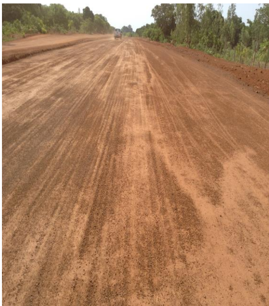
Couche de fondation mise en œuvre entre le pk3+350 et le pk6+100
