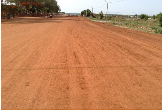
PK0+125 au pk0+375 plateforme achevé à 100%
