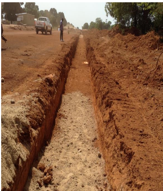
Caniveau 50x60 implanté entre le pk8+925 et le pk9+350 fouille côté droit
