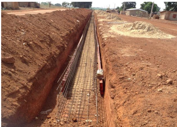
Caniveau 60x80 implanté à Moroviné entre le pk6+575 et le pk7+03 fouille exécutée à 100% radier en cours entre le PK6+600 et le PK6+750.
