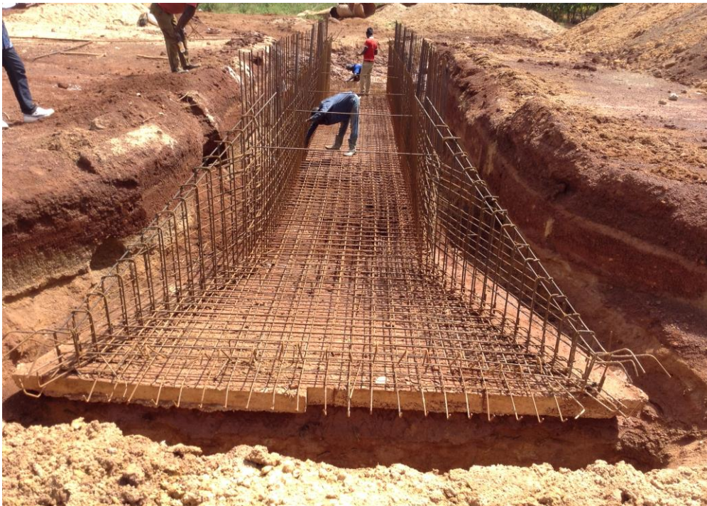
OHN°10 dalot (1x1.5x1) implanté au pk12+934 fin projet route stade Korhogo – Karakoro béton de propreté exécuté à 100% ferrailage radier et piédroits en cours.
