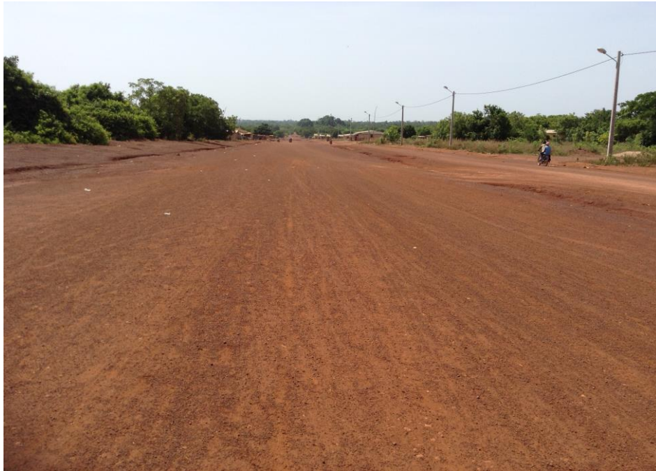
Plateforme exécuté à 100% dans la ville de Karakoro entre le pk12+100 et la fin du projet
