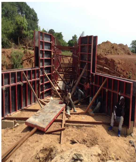
OH N°8 dalot (1x2x2) implanté au pk10+082 radier coulé à 100%, coulage piédroits en cours
