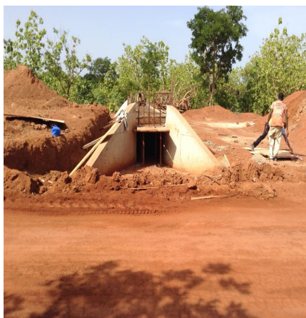
OHN°4 dalot (1x1x1) implanté au pk6+298.60 BP, radier, piédroits ferrailage tablier exécutés à 100% coffrage parois dalle en cours.
