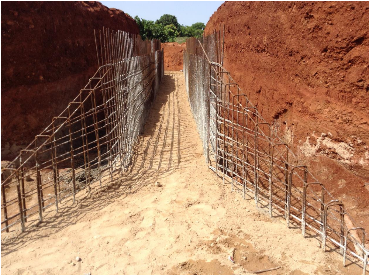
OH N°7 dalot (1x1x1) implanté au pk8+729 béton radier coulé à 100%
