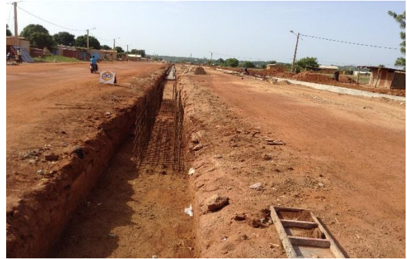
Fouille caniveau 50x60 au pk0+175 radier côté gauche, côté piédroits coulé jusqu'au pk0+400
