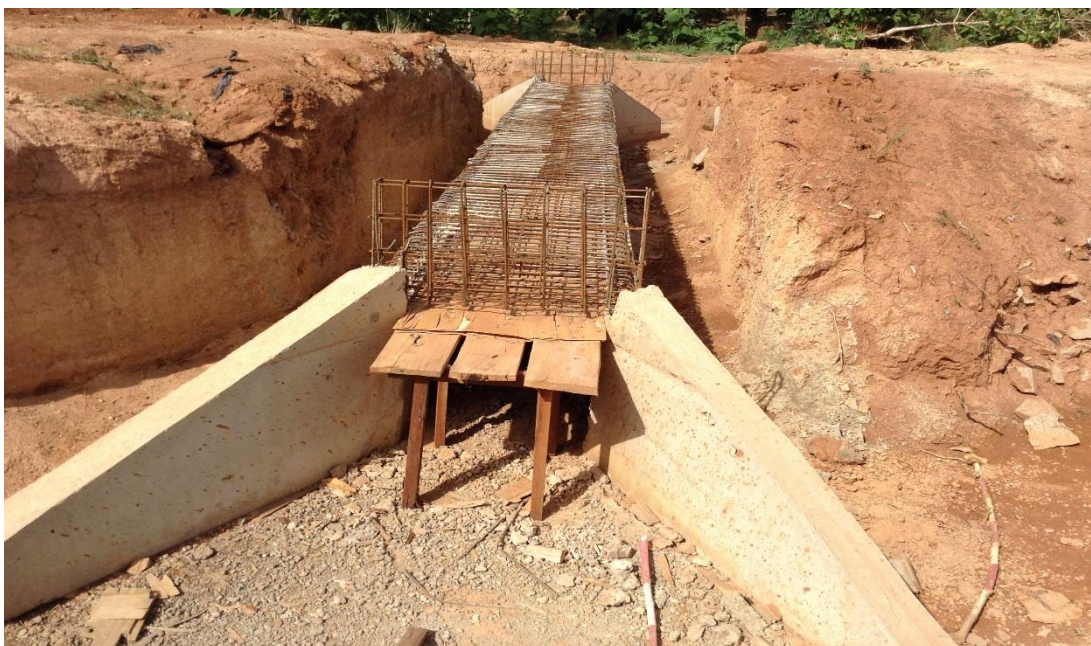
OHN°2 dalot (1x1x1) implanté au pk2+700, fouille, BP, radier, pîedroits exécutés à 100% coffrage +ferrailage dalle en cours.
